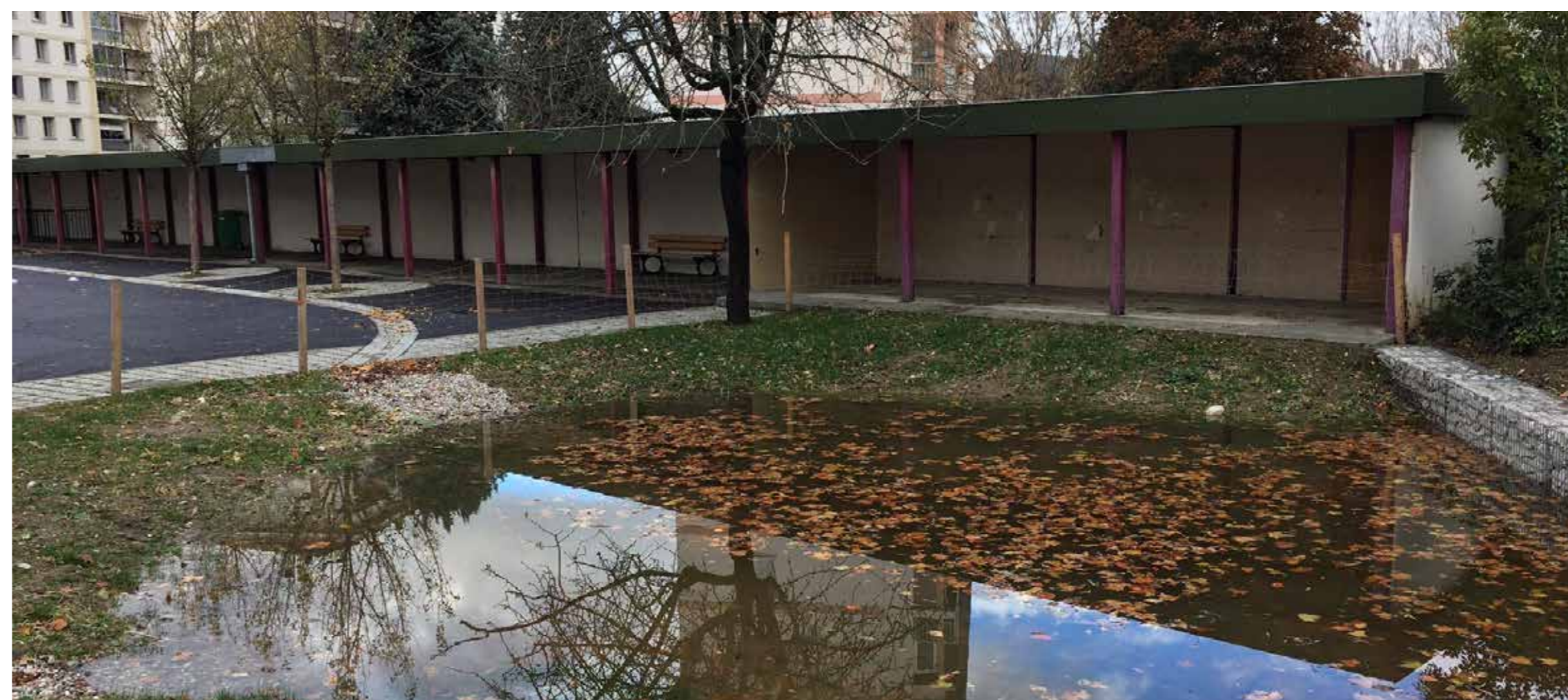
La totalité des eaux de pluie de la cour 3 et de la cour 2 sont infiltrées dans ce jardin de pluie
