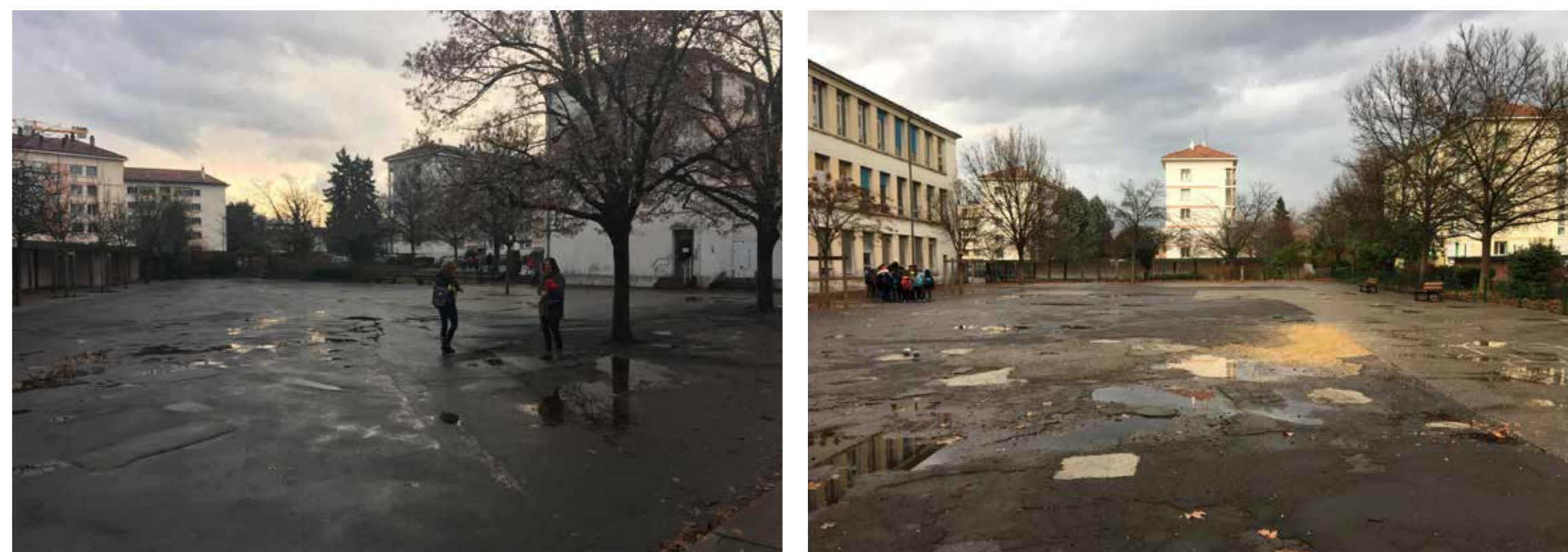
Photos de la cour avant travaux
