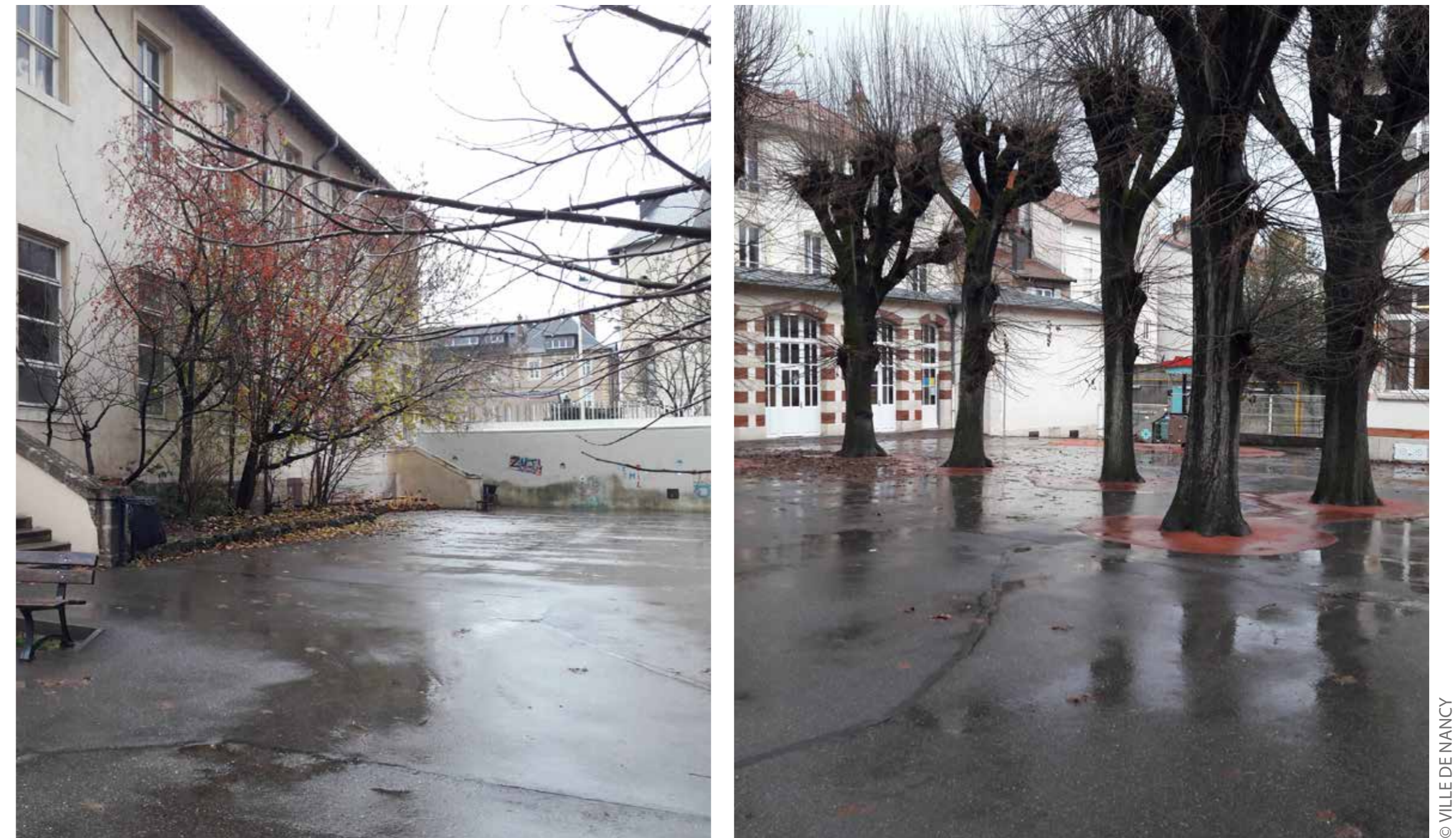
Photos de l'état avant-projet de la cour de l'école
