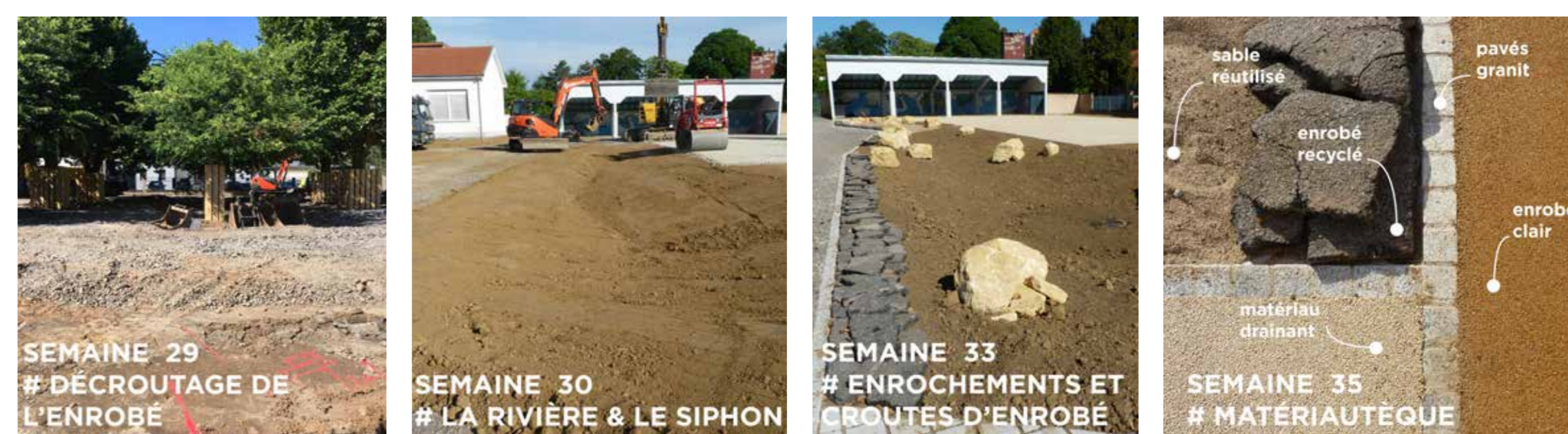
L'évolution du site : quelques images du chantier de la cour
