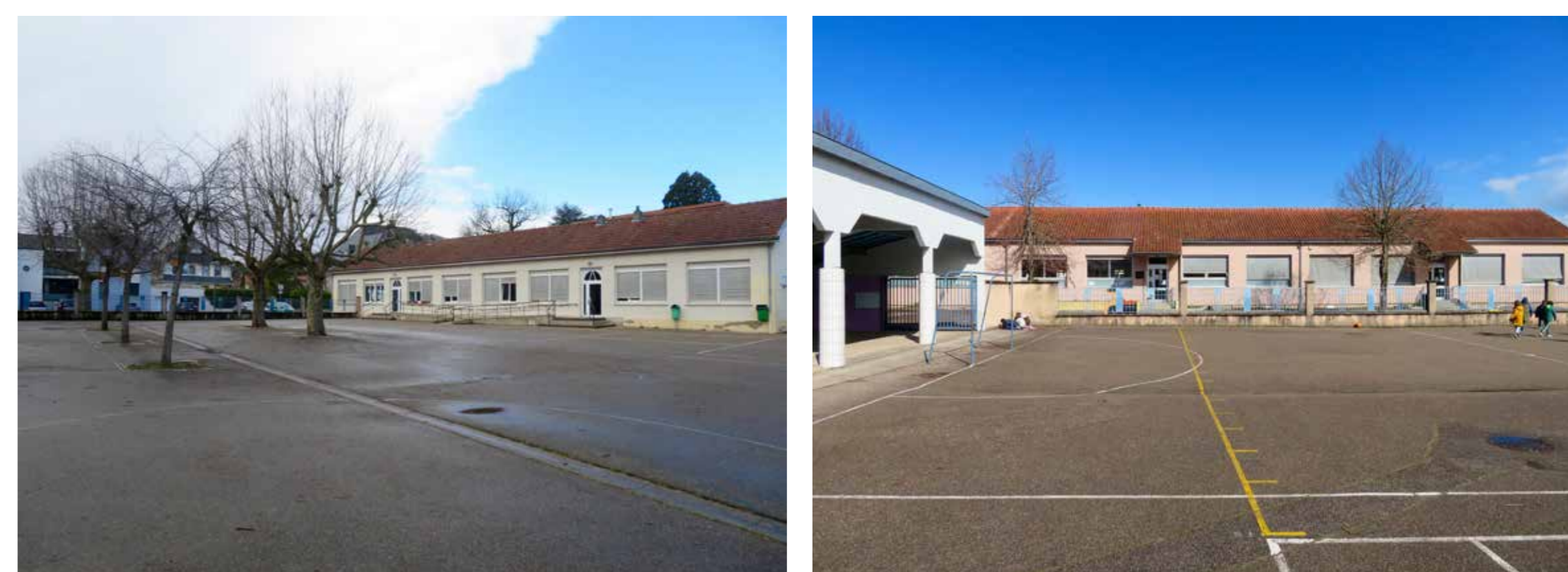
Photos de la cour avant travaux
