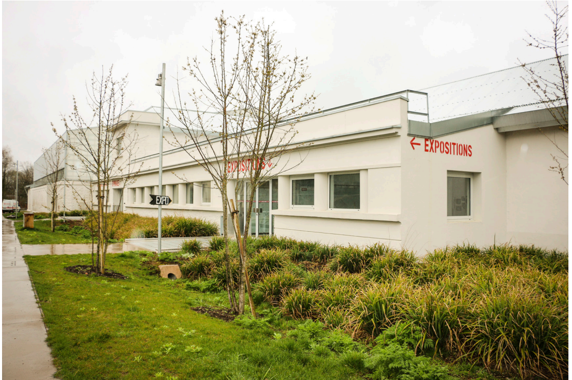
Nouvelles paysagères : gestion des eaux et traitement paysager du site
