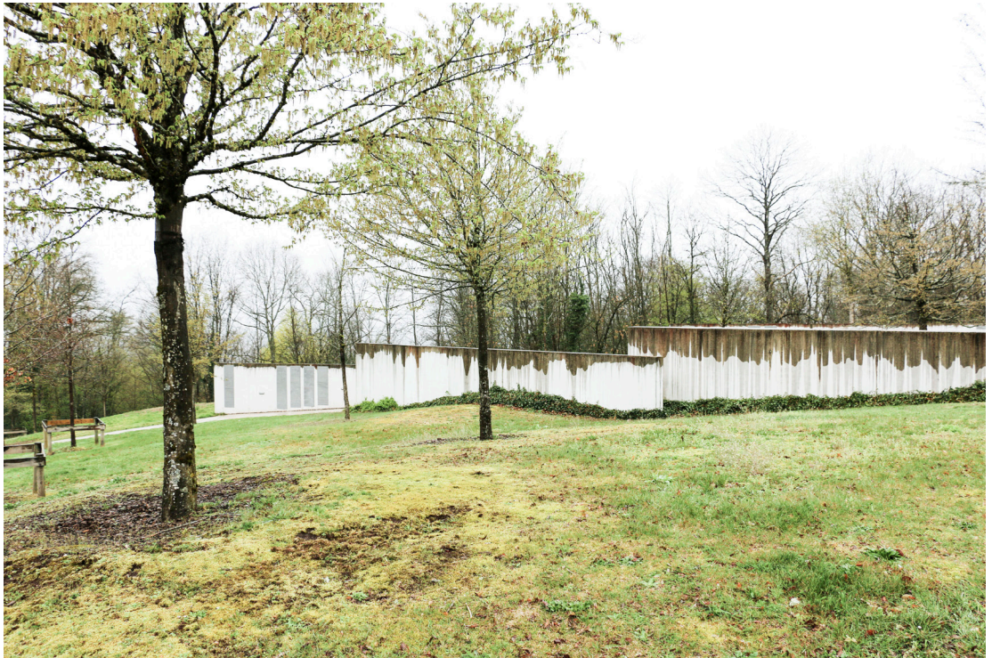
Les aménagements extérieurs : simplicité permettant de souligner la topographie
