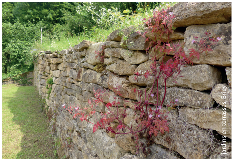
Mur de soutènement qui abrite mousses et flore spontanée.
